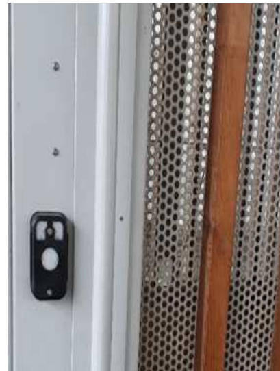
Sekundäre Zugangstür (zum Bahnsteig hin, links vom Haupttor)
