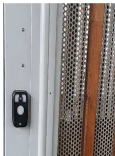
Porte secondaire d'accès
